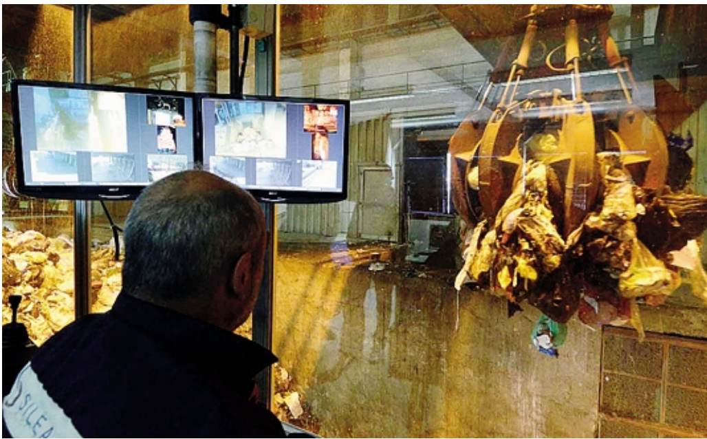
Un'immagine di una fase di lavorazione nel forno di Valmadrera
