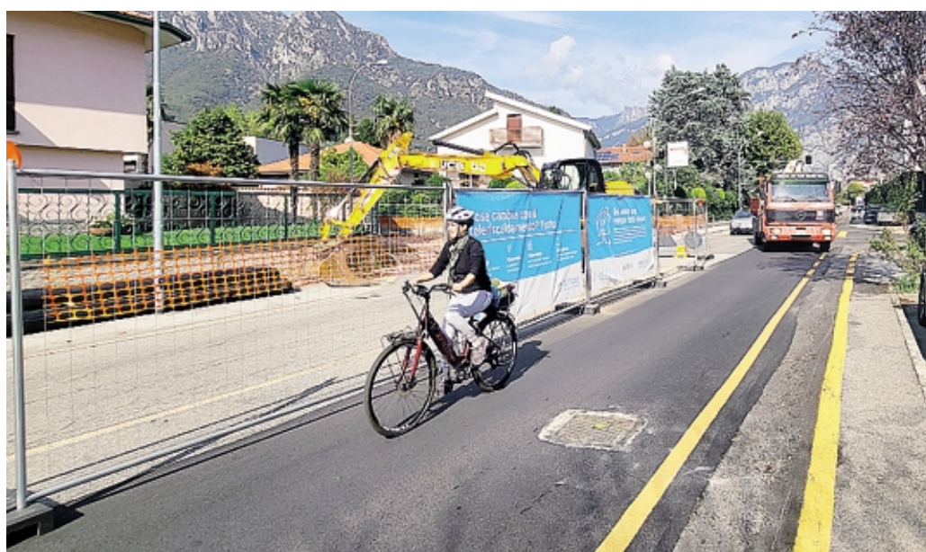
Il cantiere appena aperto a Valmadrera
