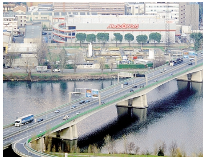
Una veduta aerea del ponte Manzoni
