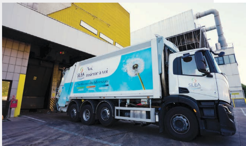
Impianto di termovalorizzazione di Silea SPA
