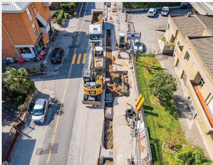
I lavori di posa della nuova rete di teleriscaldamento nei comuni di Lecco, Malgrate e Valmadrera
