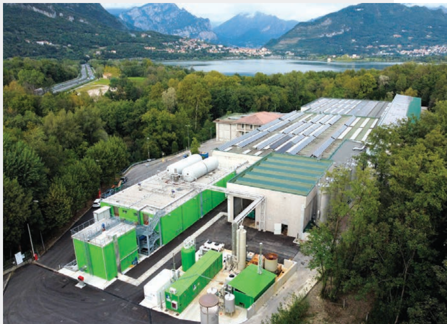
Il nuovo digestore anaerobico per la produzione di biometano
