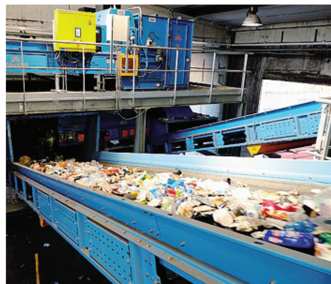
L'impianto di Seruso
